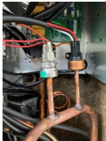
CN-HPS: Hoge druk sensor (rechts) en de CN-PSW : hoge druk schakelaar (links)
