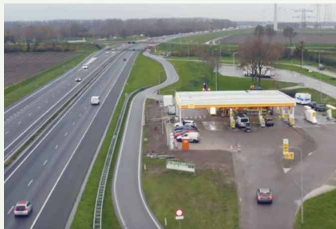
Warmtepomp bij Shell tankstation Buttervliet. ECOi W
